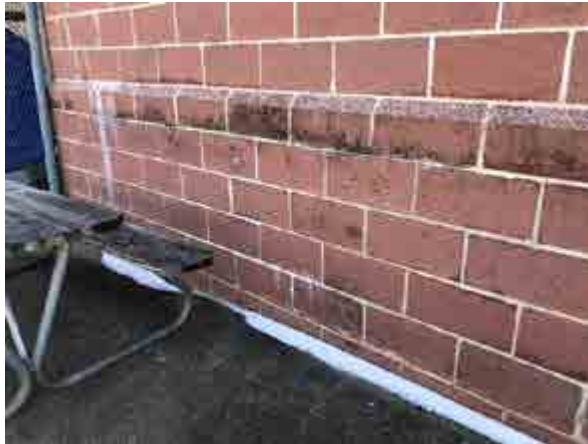
AVCE-1 Exterior CMU Wall Water Table
