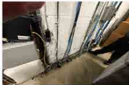
Cable System Riser Conduits
